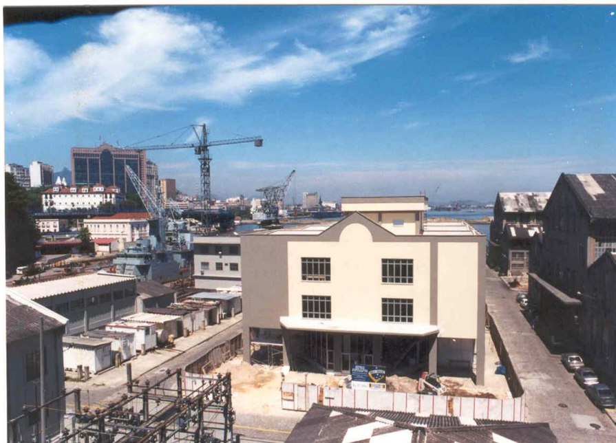
Figura 3 – Edifício 35 em fase final de construção
